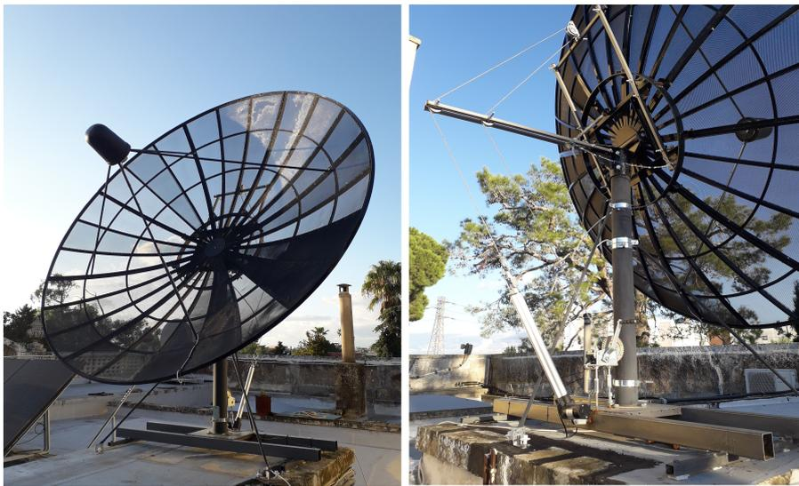
Antenna Mesh da 3 metri di diametro per frequenze più basse (1420 Mhz)
